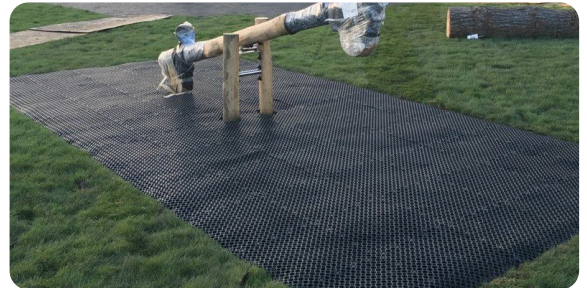
Dalles posées sous l'équipement
